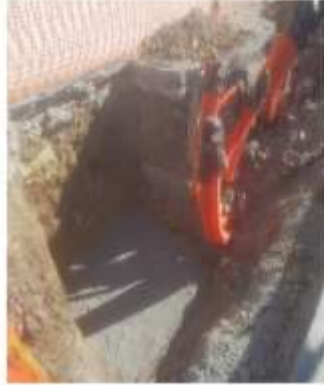
PREPARACIÓN PARA COLOCACIÓN DE REGISTRO DE MEDIA TENSIÓN.
