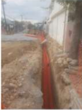
TENDIDO DE DUCTOS ENTRE ABASOLO Y JIMÉNEZ
