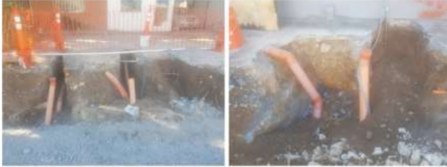
CONEXIÓN DESCARGAS DOMICILIARIAS.
