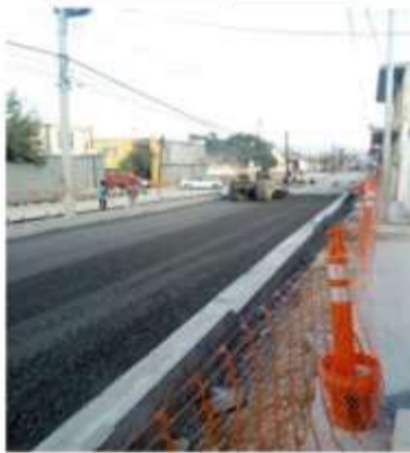
COMPACTACIÓN DE BASE ENTRE CALLES DE ALLENDE E HIDALGO CUERPO SUR
