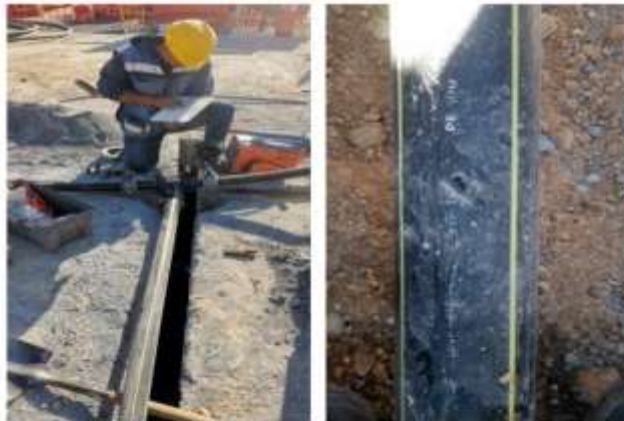
CONEXIÓN EN CALLE JIMENEZ
