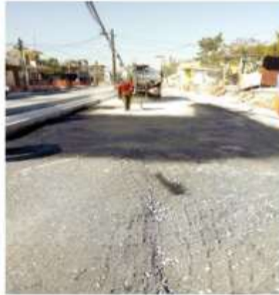
RIEGO DE IMPREGNACIÓN ENTRE CORREGIDORA E HIDALGO, CUERPO NORTE.
