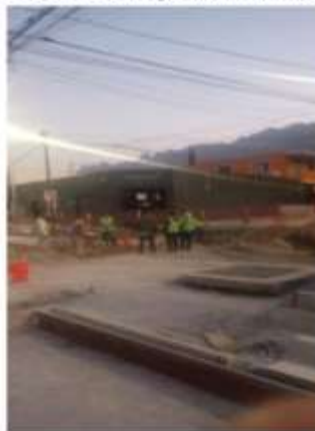
CONEXIÓN EN CALLE HIDALGO
