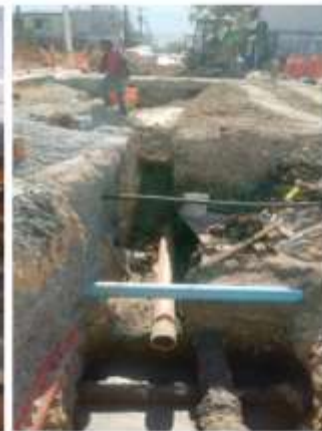
CONEXIÓN EN CALLE ABASOLO
