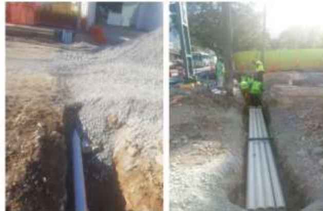
INSTALACIÓN DE MANGAS PARA CRUCE DE TUBERÍA EN CALLE HIDALGO LADO ORIENTE
